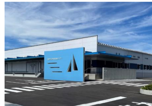
岡山県玉野市立学校給食センター
