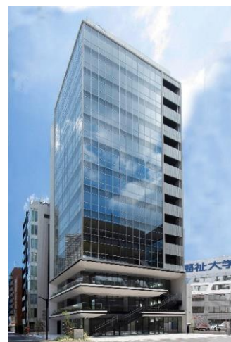
「Commune Plaza」が入居する UPROVEMENT 外観
