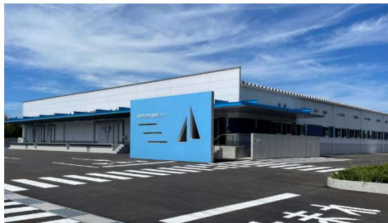
玉野市立学校給食センター 外観
